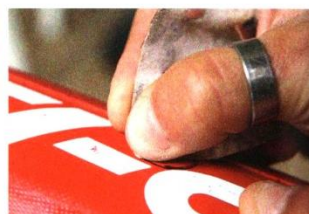
2 Mit Schmirgelpapier die Oberfläche an der kaputten Stelle aufrauen und mit Aceton reinigen.
